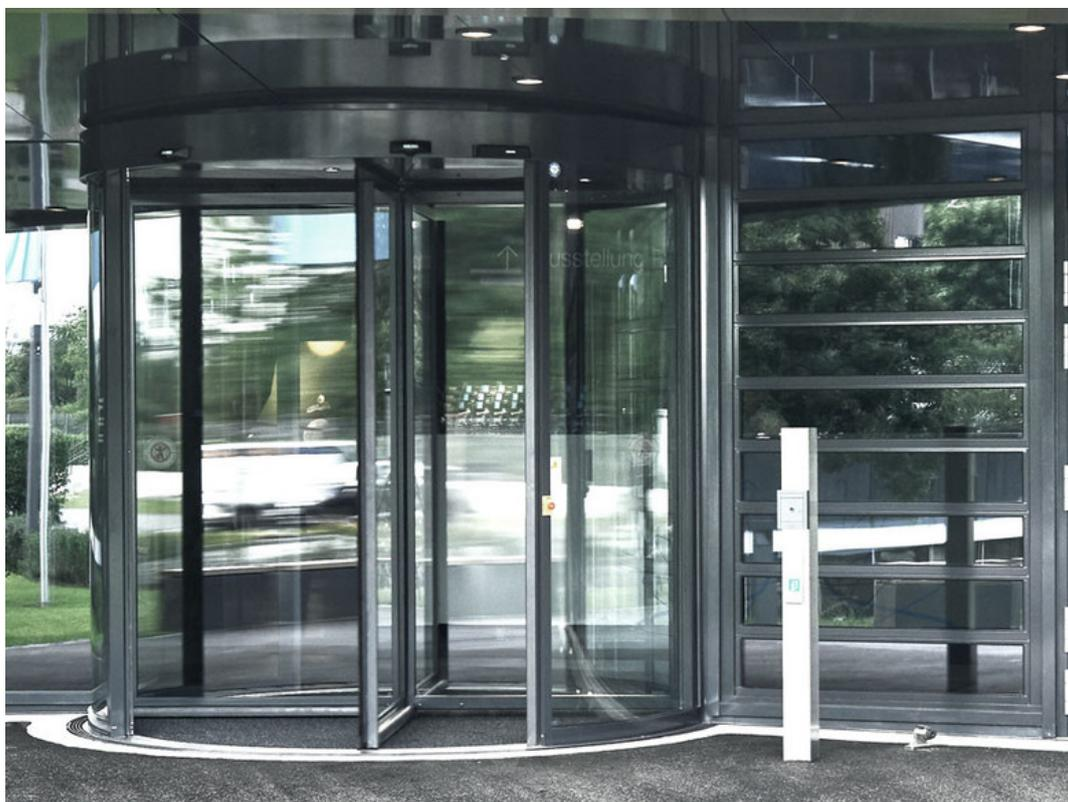
Système de porte tournante automatique avec une protection anti-effraction selon la classe de résistance 2.
